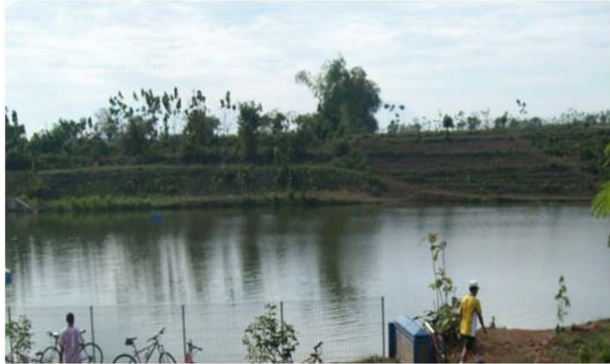
Gambar 6. Embung untuk tempat penampungan air hujan.
